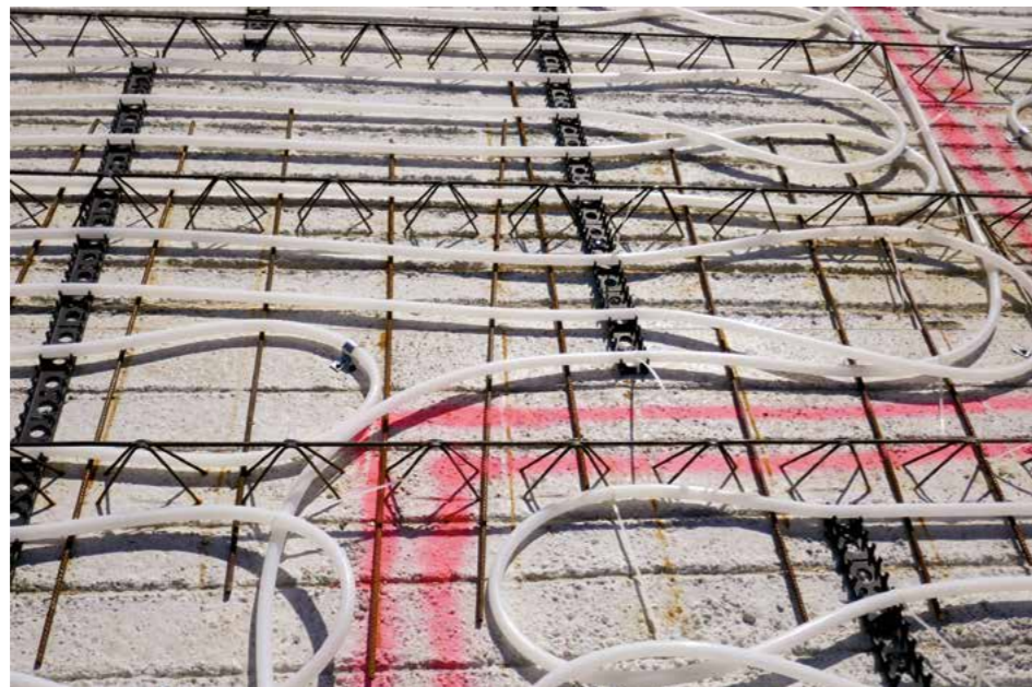
Verlegung Bauteilaktivierung
