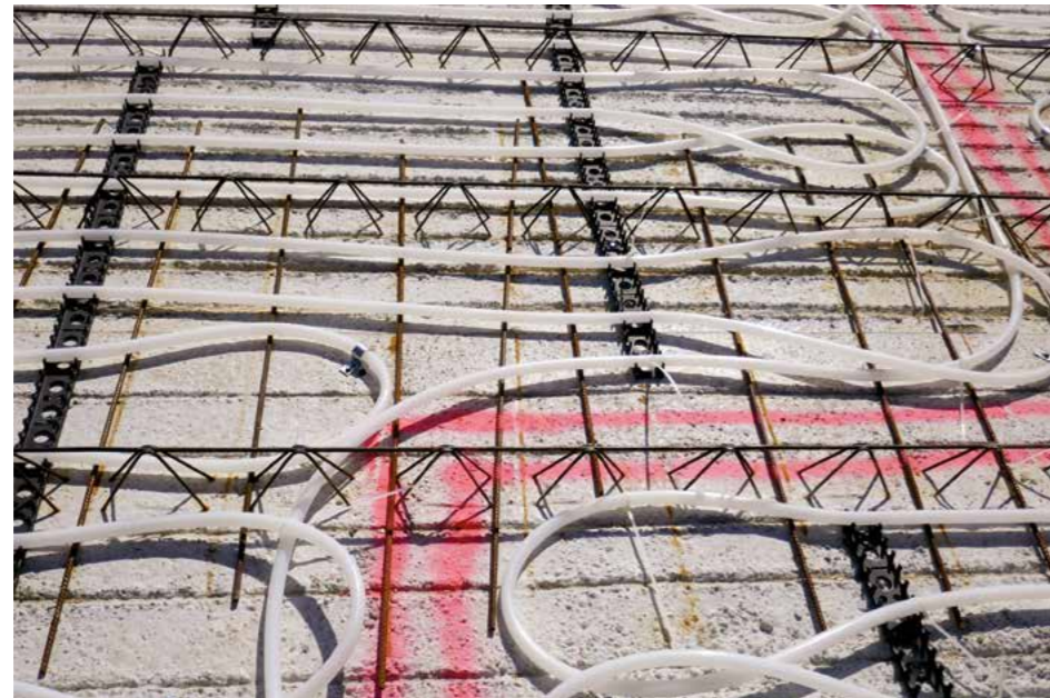
Verlegung Bauteilaktivierung
