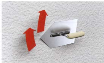
Putz abscheiben und strukturieren
