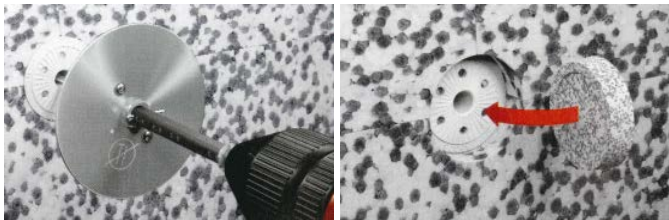
Versenkte Montage Schraubdübel mit Rondelle
